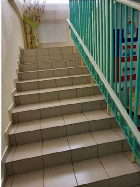
Фото №7 Лестница (внутри здания)
