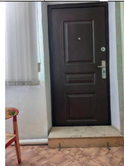
Фото №14 Дверь запасного выхода № 8
