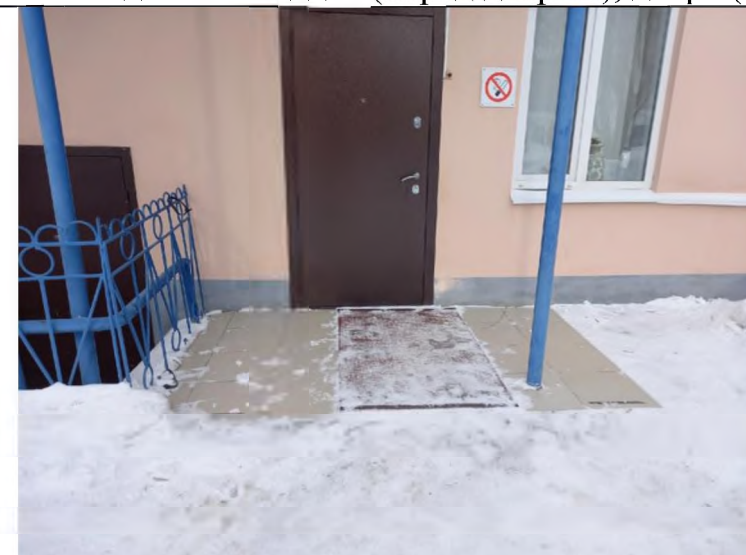
Фото № 4 Входная площадка (перед дверью), дверь (входная)
