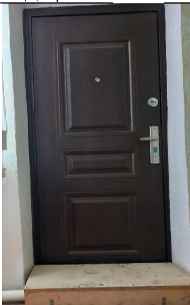
Фото №15 Дверь запасного выхода № 7
