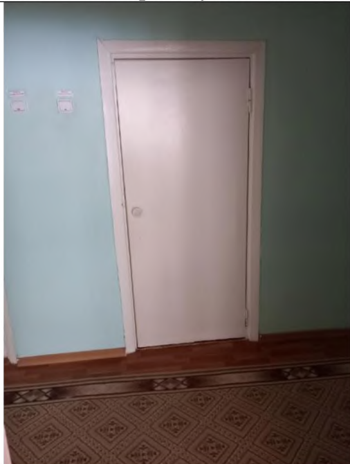
Фото № 25 дверь в туалет на 1 этаже
