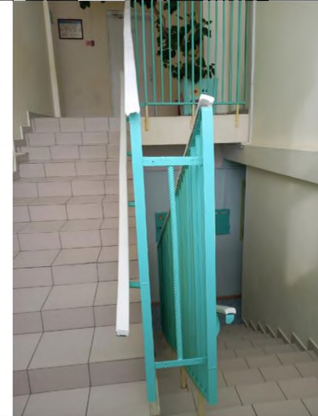
Фото №8 Лестница (внутри здания)
