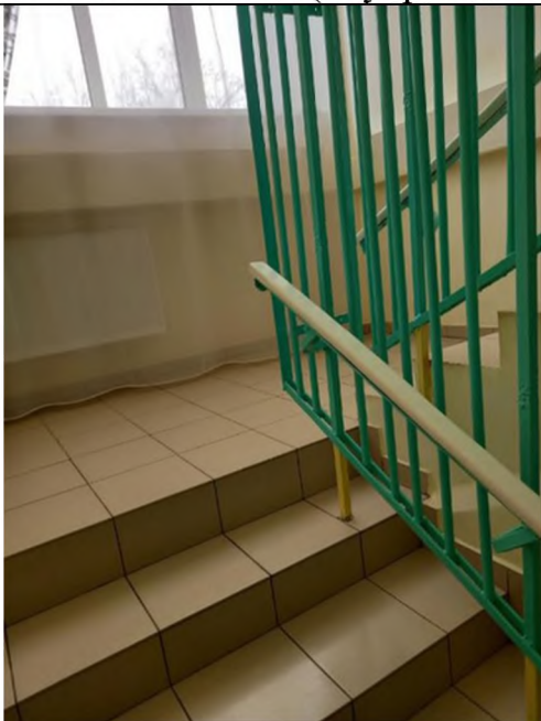
Фото №9 Лестница (внутри здания)
